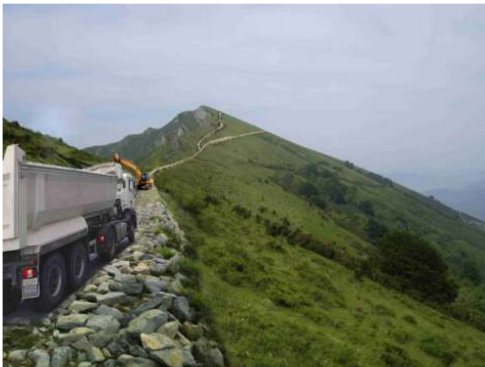
Ganekogorta en obras
