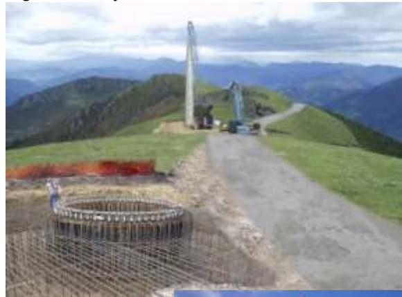
Destrucción prevista: construcción de zapatas e instalación de los molinos con grúas de gran tonelaje
