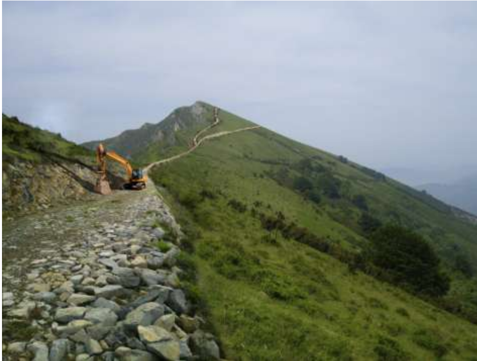
Ganekogorta en obras
